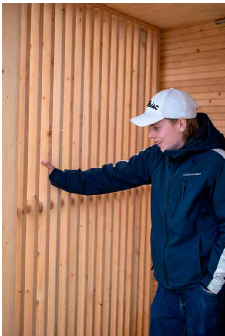
Tide viser frem noen av delene han har jobbet med. Byggverket inneholder trekonstruksjon som krever mye nøyaktighet.
