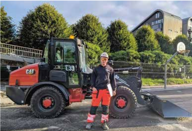
Benjamin Ro fra Landskapsentreprenørene skal bl.a. sørge for nytt gummidekk på banen for fotball og basket, ny lekeplass for de minste under gangbrua og ny sykkelparkering, ny sittegruppe og pergola ved Dampveivalsen. Foto Sigrid Bækholt
