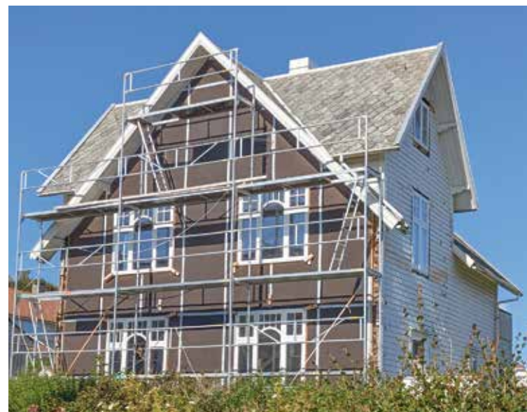
Hus i Høleveien restaureres i sveitserstil. Foto Sten Solberg
