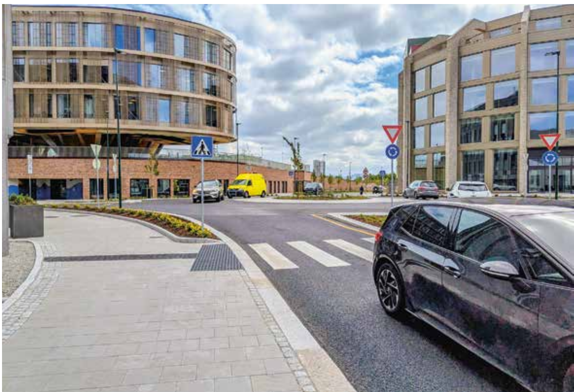
Hele Haugesundsgata er nå åpen for trafikk igjen. Det ovale kontorbygget til venstre i bildet er det høyeste bygget i Lervigkvartalet. Det er løftet én etasje over skolegården, som dermed får deler av lekeplassen under halvtak. I dette bygget holder kommunens pedagogisk-psykologiske tjeneste (PPT) til. Lervig Bydelstorg er i første etasje med store vindusflater ut mot rundkjøringen. Hovedinngang for PPT og Lervig Bydelstorg er fra Rennesøygata.
