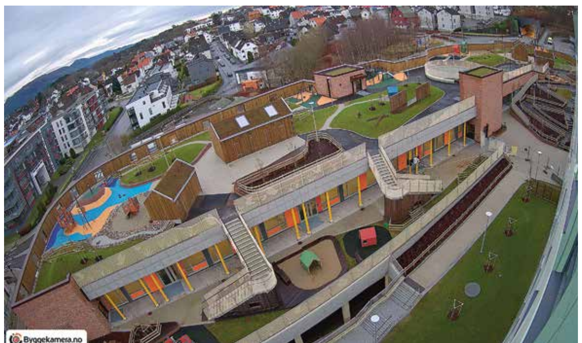
Oversiktsbildet fra barnehagens uteområde er tatt fra et byggekamera.
