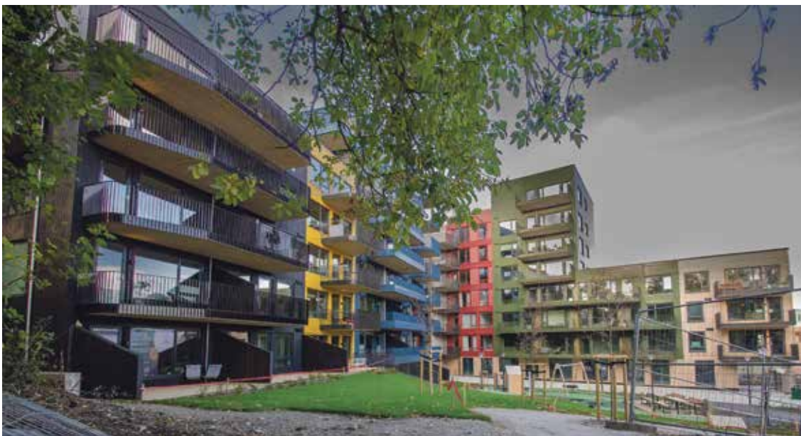
Første byggetrinn av Fargehusene i Steinhagen er nå ferdige. Til neste byggetrinn planlegges flere bygg med til sammen 64 leiligheter.
