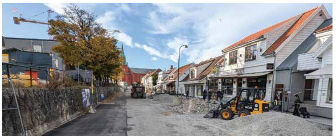
Vann- og avløpsledninger fornyes. Masser skiftes ut på hele nedre torg for å få godt fundament for parken som skal bygges. Det blir lagt ny gassledning fra Nykirkebakken til Langgata og inn i Pedersgata. Går alt som planlagt, kan parken på nedre torg åpne mot slutten av 2025, også for varelevering. Mer informasjon på kommunens nettside.
