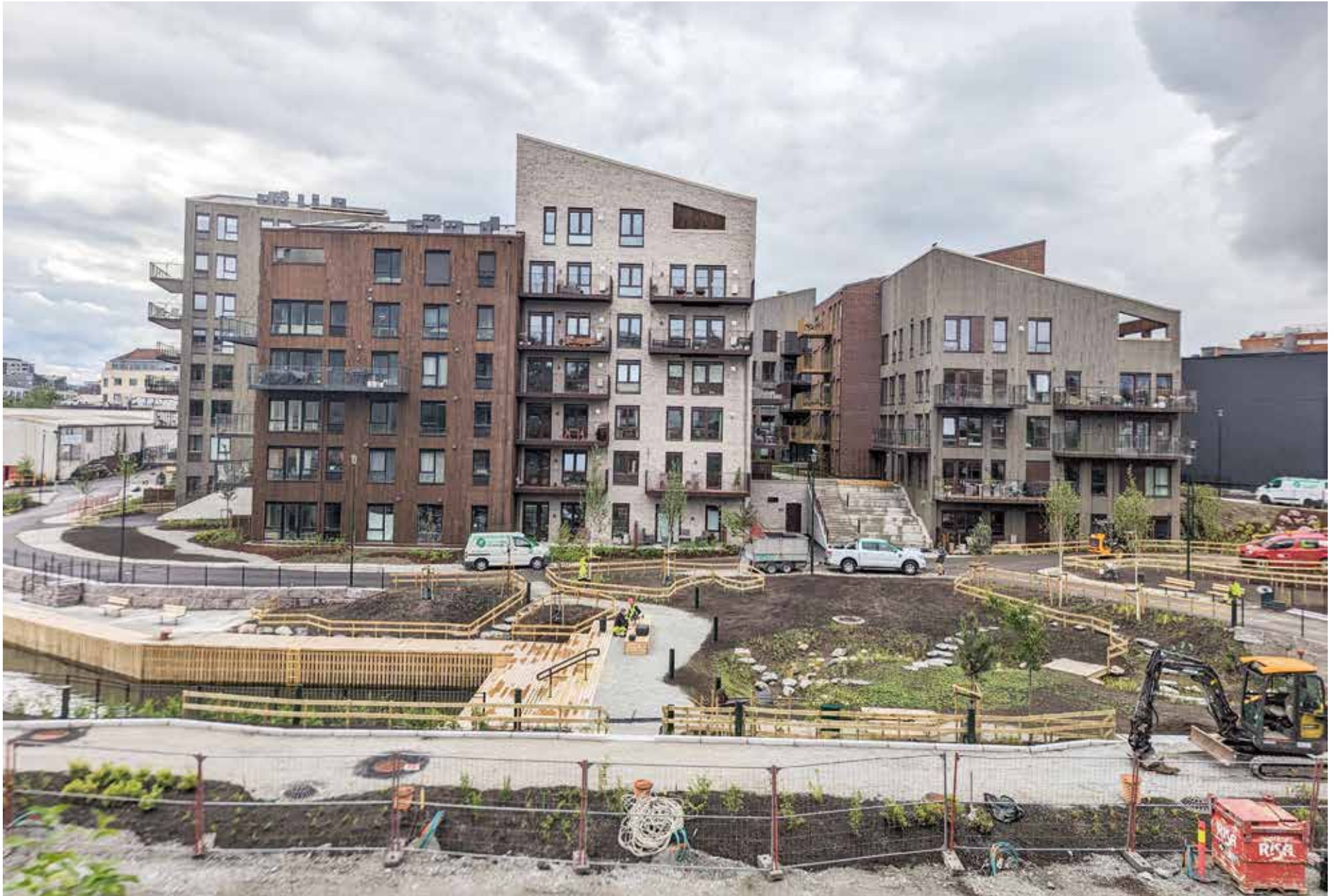
Det nye boligprosjektet ved Spilderhaug består av fem blokker med til sammen 161 leiligheter. Innflytting startet i februar i år. Blokkene har innkjøring fra Lervigsveien, helt til venstre i bildet, til en underjordisk parkeringskjeller og har dermed et bilfritt uteområde mellom blokkene..
