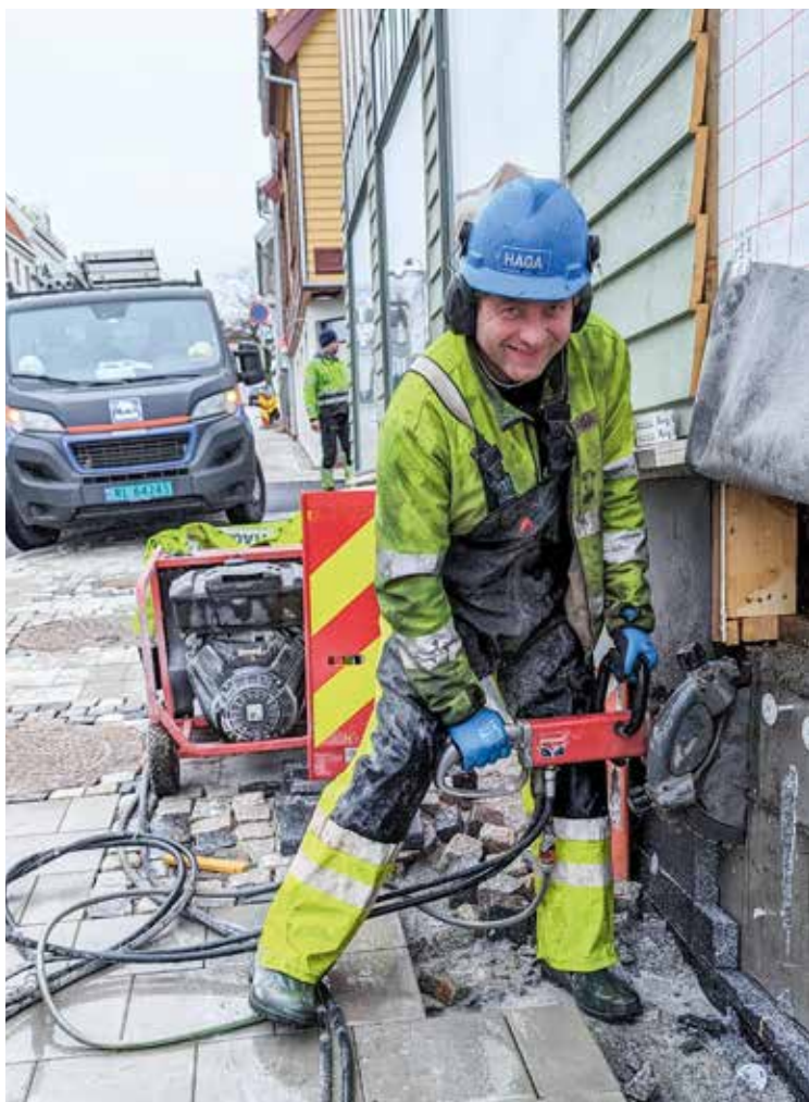
Når gate og fortau opparbeides på ny betyr det også ekstra tilpasningsarbeid for huseierne. Men fint blir det! Foto Sigrød Bækholt.
