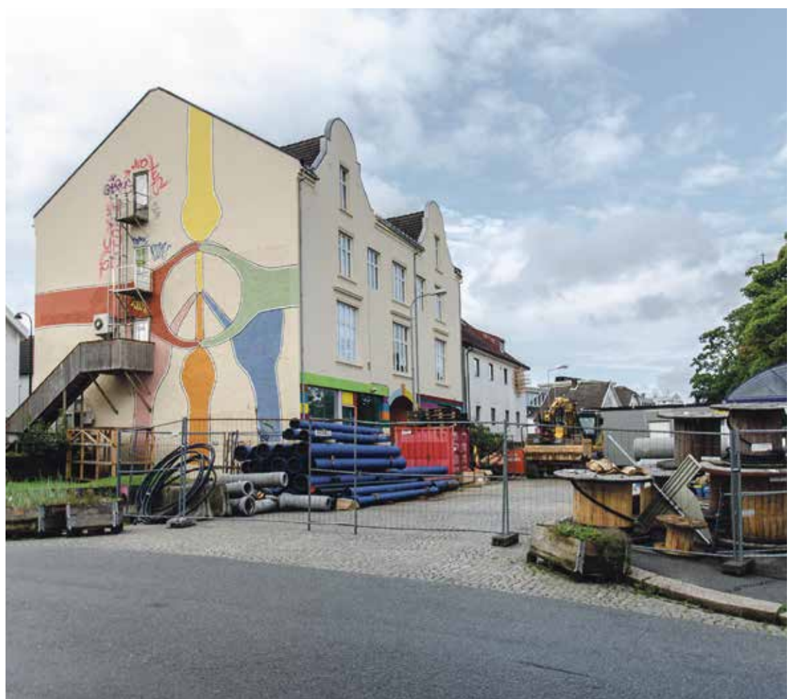
Slik ser det ut ved Rogaland Kunstsenter på Nytorget akkurat nå. En stor del av torgområdet er riggområde for byggeprosjekter.
