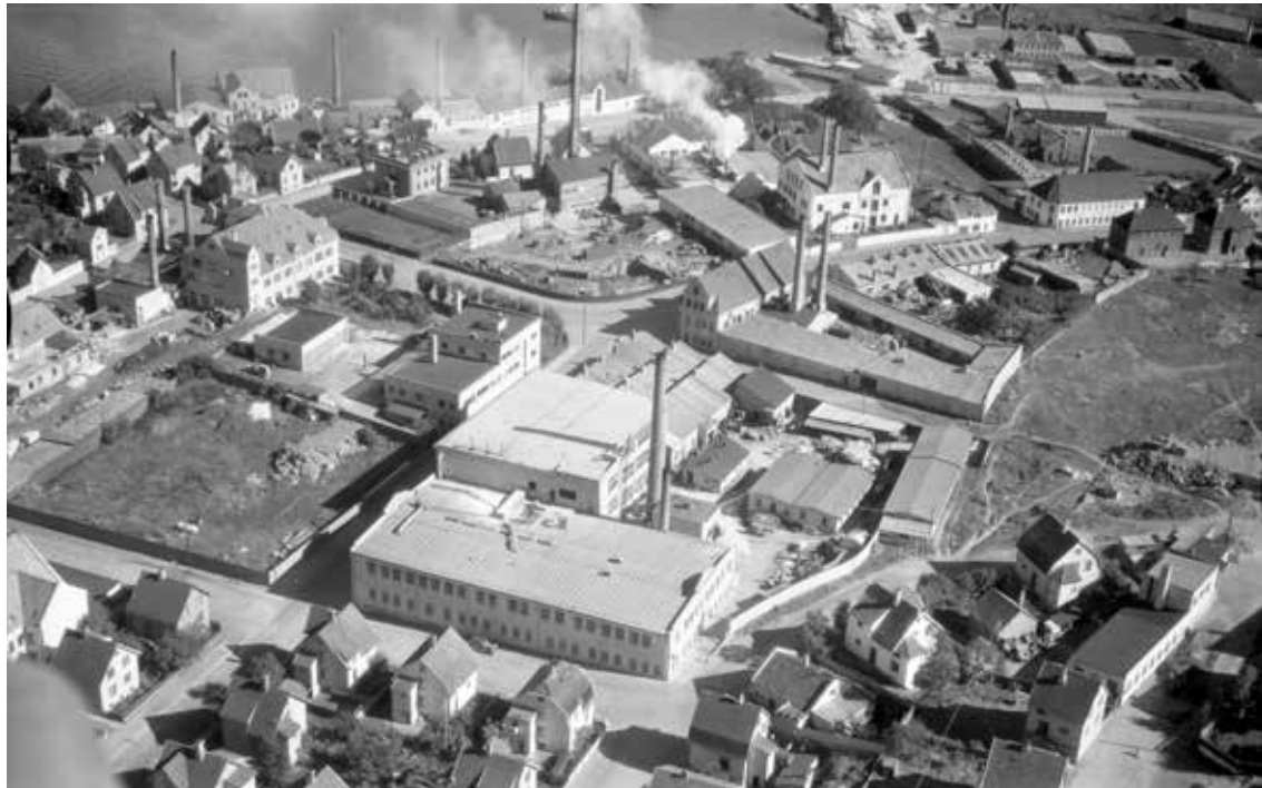
Gummien var Stavanger nest største arbeidssted, og hadde på det meste 900 ansatte. Vestlandske Gummivarefabrikk hadde adresse Haugesundsgata 27-29. Widerøes flyfotosamling/Stavanger Byarkiv datert 1.9.1950.
