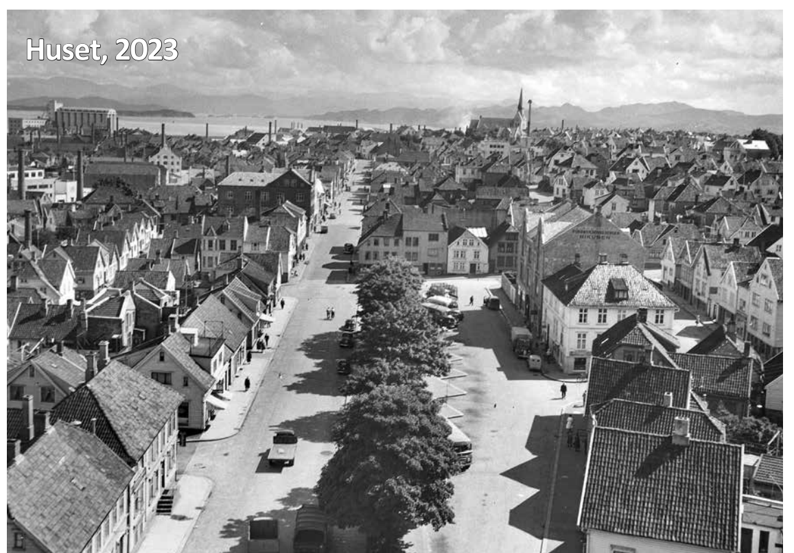
Det hvite hjørnehuset som ses litt til høyre for midten av bildet har adresse Nedre Dalgate 2. -Vi vil gjerne høre flere historier om dem som har bodd i huset. Det er bare å banke på når vi er i huset, forteller Evy Horpestad Tjåland og Markus Bråten som er med i prosjektets arbeidsgruppe. Om bildet: Utsikt fra Petrikirken. Formannskapets samling/Byarkivet i Stavanger med omtrentlig datering ca 1950 til 1960.
