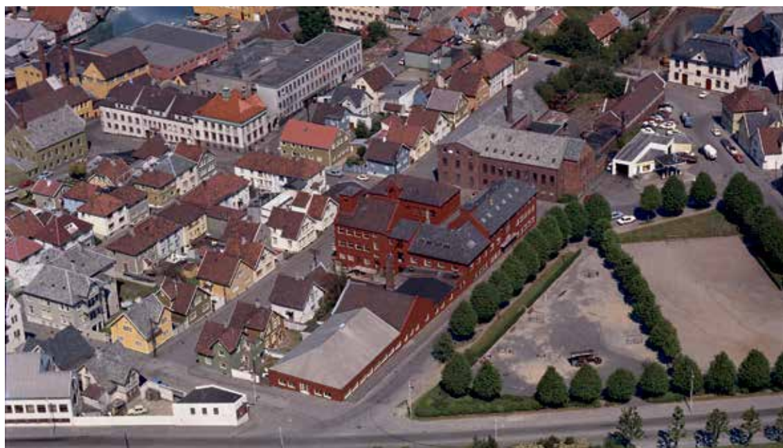
Slik så det ut før Bybrua ble bygd og før Haugesundsgata ble gravd ned i terrenget med kulvert over. De hvite byggene foran til venstre er Stavanger-Fjord Packing. De røde bygningene i midten er Stavanger Gummiindustri (Gummi). Arbeiderboligene i Spilderhauggata 1, 3 og 5 lå i gårdsrommet til Gummi. Øverst til venstre Svankevigå (som av mange ble kalt Banavigå). Øverst til høyre Spilderhaugvigå. Mellom Stavanger Støberi & Dok og Gummi ligger Mauritzen såpefabrikk. Widerøes flyfotosamling, Stavanger Byarkiv. Datert 19.6.1970.
