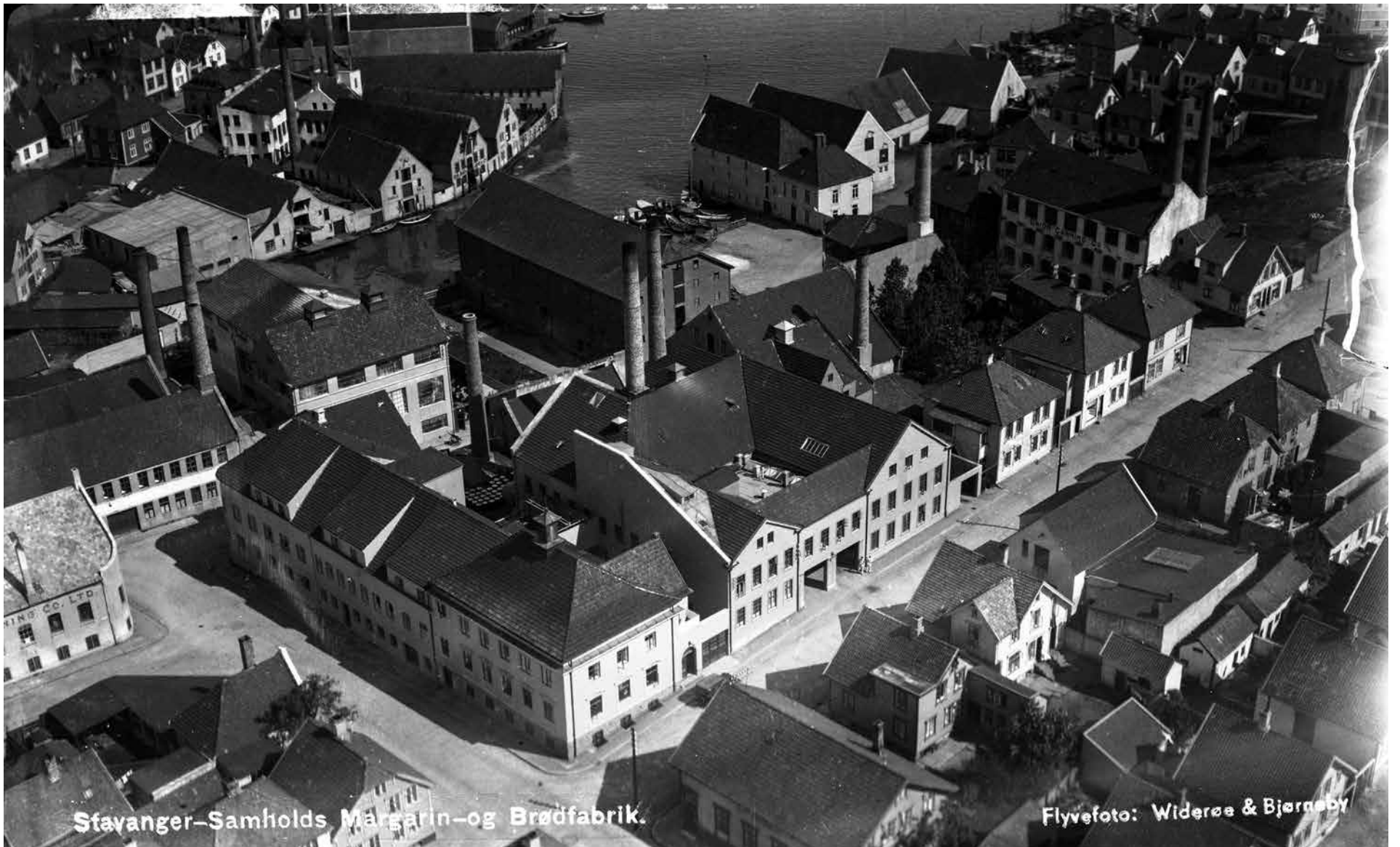
Samholds Margarin- og Brødfabrik dominerer Pedersgata fra vest mot øst. Harald Hårfagres gate i forgrunnen med Produksjonslaget Samhold til venstre og bedehuset Betesda til høyre. Bildet er tatt mot Svankevigå og Strømsteinen. Vindmøllen i øverste høyre bildehjørne. Widerøes flyfotosamling/Stavanger Byarkiv med omtrentlig datering 1937 til 1940.
