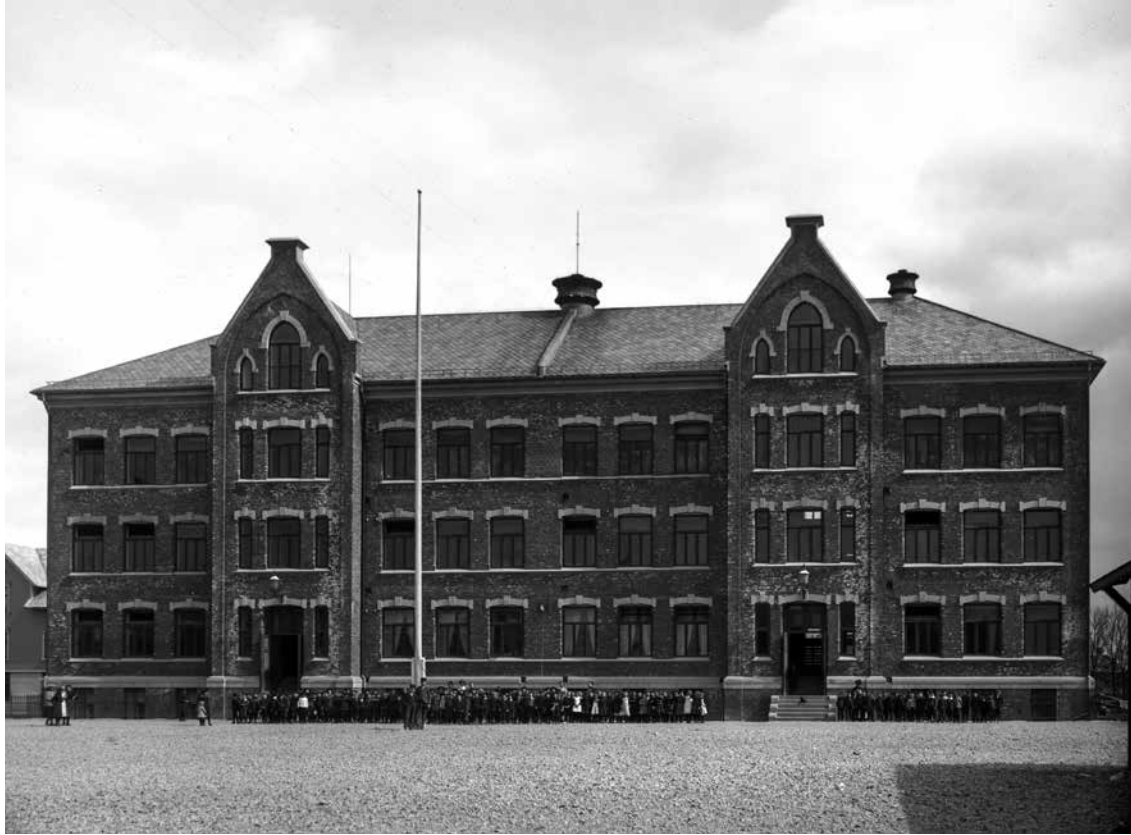
Skolen ble tatt i bruk 18. august 1902 og bildet er nesten like gammelt. Den tre etasjers murbygningen ble tegnet av Hans L. Juell, som også var prosjektleder for byggingen. Den besto av 22 klasserom, pluss en kjelleretasje med sløydrom, bad og rom for sentralfyring. I tillegg ble det reist et ekstra bygg til gymsal og vaktmesterbolig. Siden elevene var delt i jente- og gutteklasser, ble det også laget egen inngang for jenter og gutter. Guttene brukte den venstre inngangen av skolen og jentene den høyre. Det samme gjaldt for lærerne.
