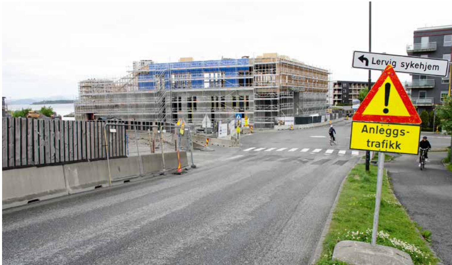
Til venstre ses deler av byggegjerdet rundt det nye Lervigkvartalet. Midt i bildet bygges den nye brannstasjonen. Foto Sten Solberg.
