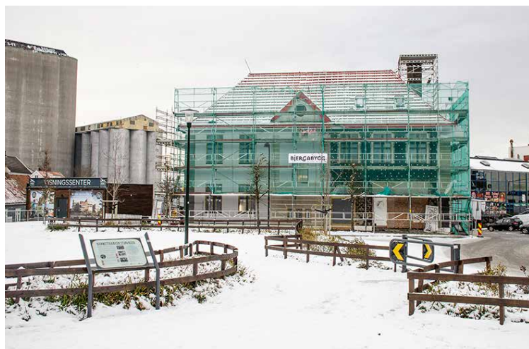
Det gamle administrasjonsbygget til Stavanger Støberi og Dok i Støperigata 18 er for tiden innekledd med stillas og sikkerhetsnett. Bygget skal romme ny restaurant, kontor og bolig og eies av Orkan Invest Eiendom. Foto Sten Solberg.
