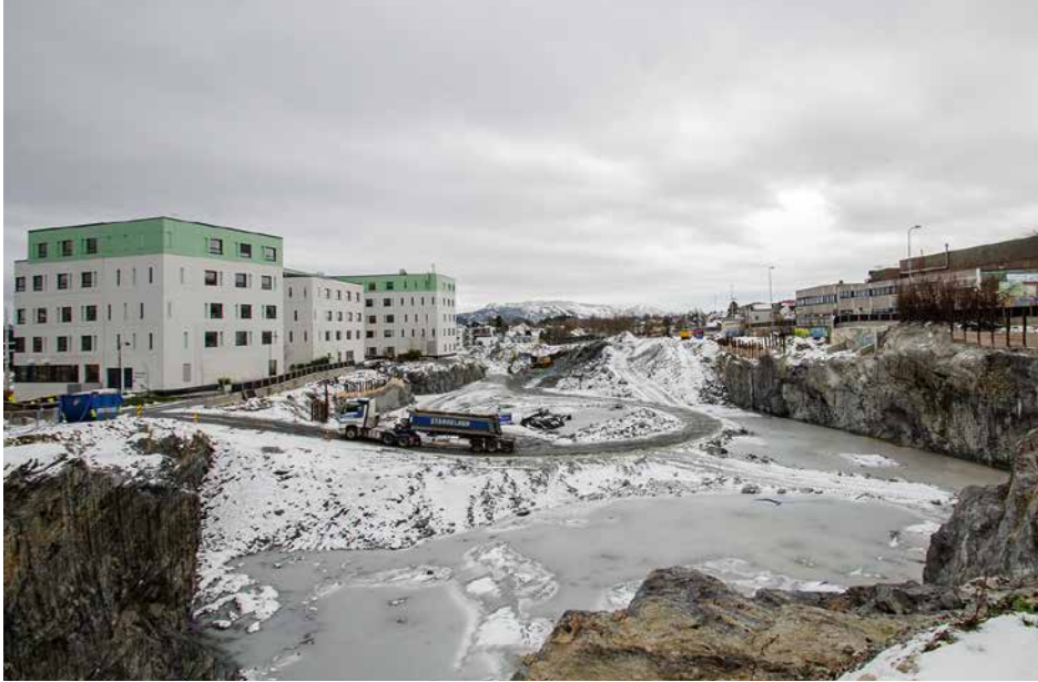
Stangeland Maskin AS er i full gang med utgraving av tomten til Lervigskvartalet, og skal etter planen ferdigstille dette arbeidet i mars/april neste år, forteller Jan Reidar Hammer.
