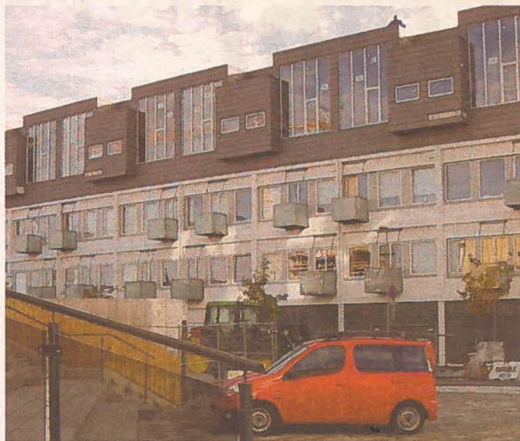
Bjellands gamle bygning på Verven inneholder nå små kubeleiligheter.
