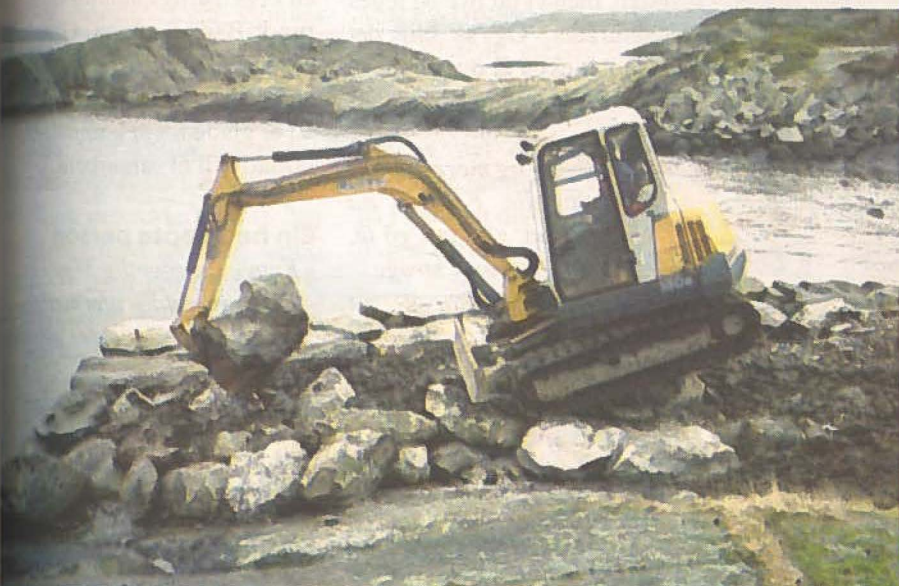
Gravemaskinen har gjort underverker med den gamle steinbrygga.
