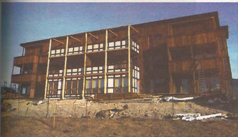
Slik blir lavblokken KleppHus AS starter byggarbeidene på rundt årsskiftet. Blokken plasseres i nordre del av Spikerfabrikktomta. Tilsvarende bygg finnes allerede i Smeaheia i Sandnes kommune.
