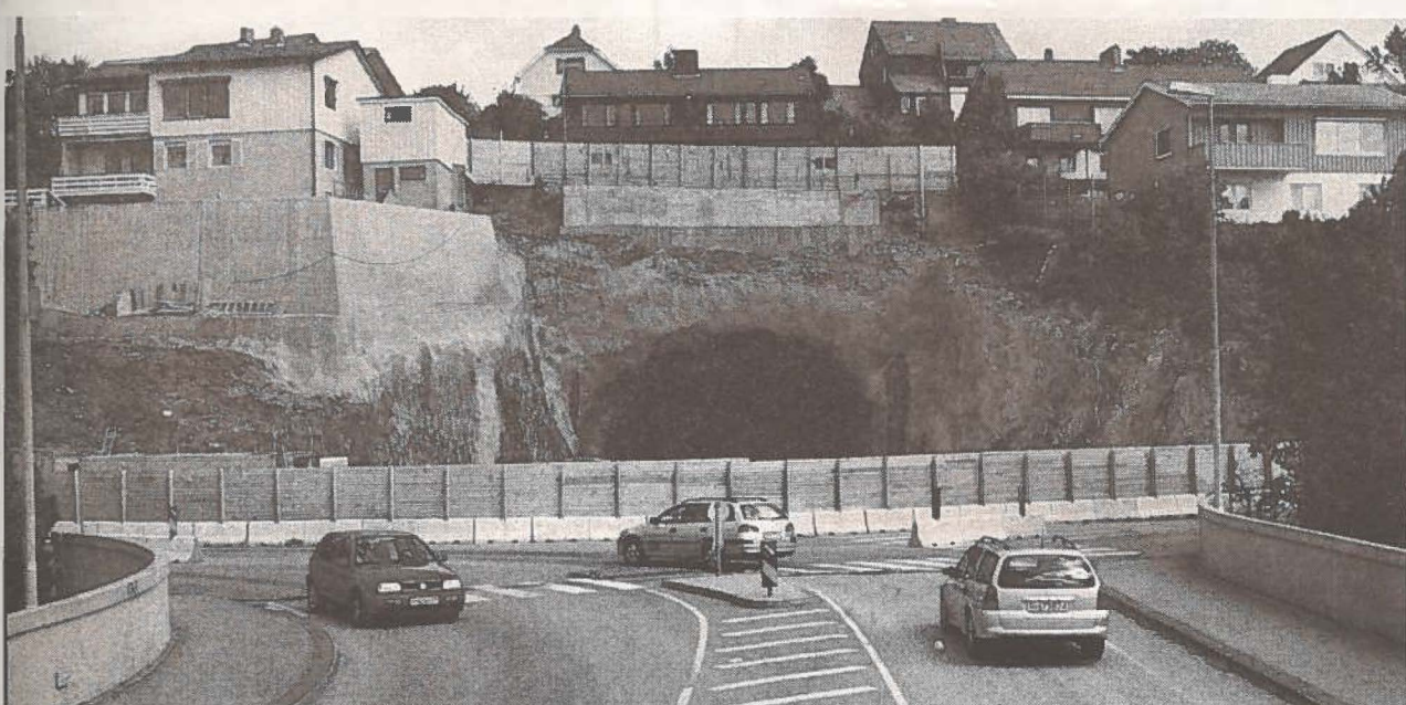
Trafikken skal ledes av Strømsbrua og rett inn i Storhaugtunnelen. Til venstre viser ennå den solide sikringsmuren, som etter hvert skal kles med lødde steinmurer. Også på høyre side skal det løses opp murer. Frontveggen blir i svart stein og rett over inngangen skal det være blomsterbed.
