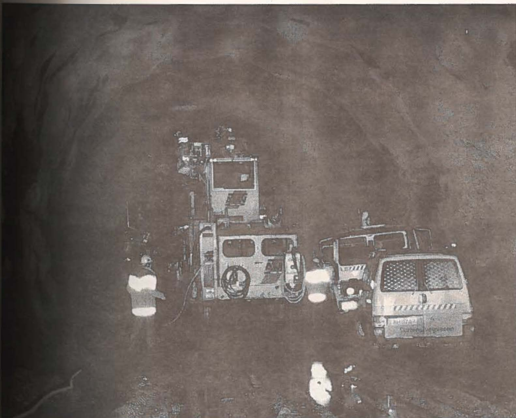
Tunneldrivinga under Storhaug nærmer seg slutten. Statens vegvesen har sprengt ut 925 meter av den totalt 1280 meter lange tunnelen.
