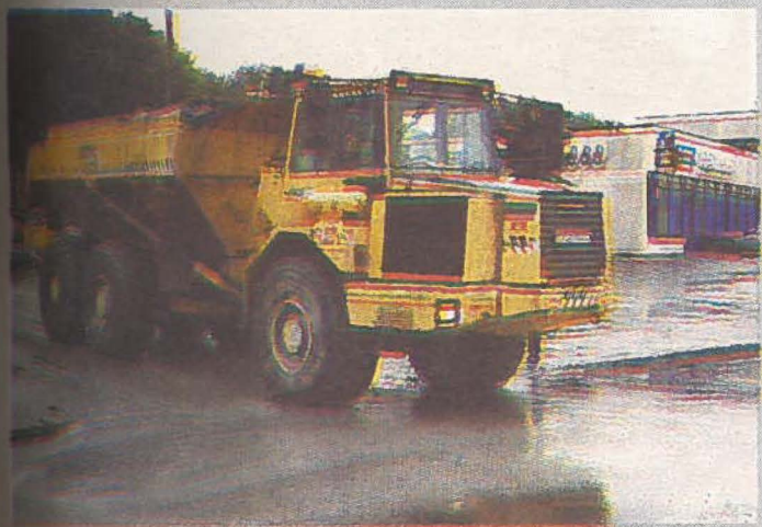
Store dumpere med tung last krysser Haugesundsgata ved anleggsområdet. Det oppstår farlige situasjoner dersom bilistene ikke respekterer lysreguleringa som gir anleggstrafikken forkjørsrett.
