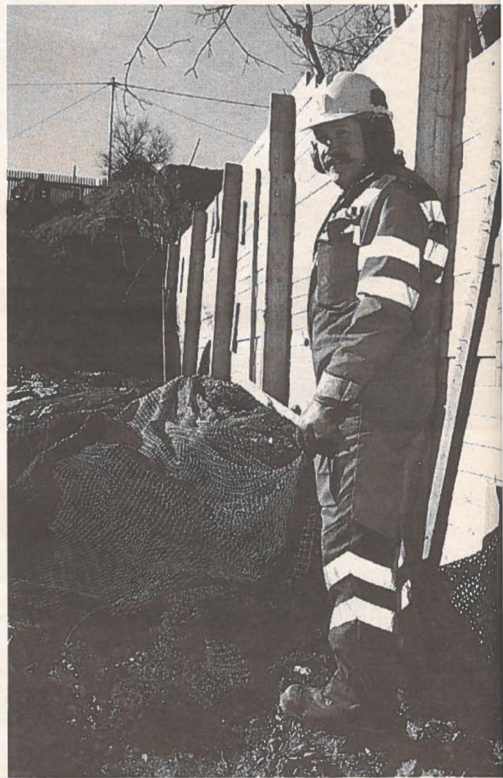
Nettene som skjermer mot steinsprut er laga av solide trålpoper. Tunnelarbeider Olav J. Stokknes gjør klar til første salve. (Foto: Birgit Høiland Gudmestad)
