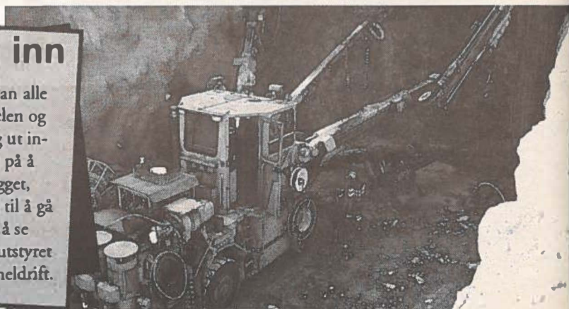
Hullene til sprengladningene blir boret inn i fjellet med denne riggen. I løpet av en arbeidsdag kan tunnelgjengen bore, lade og sprengre to salver. (Foto: Birgit Høiland Gudmestad)
