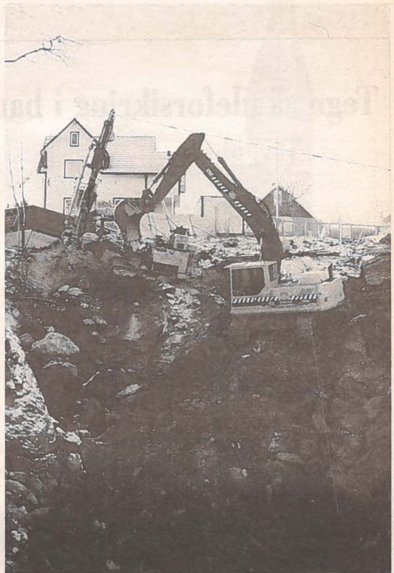
I februar har to fagarbeidere og to-tre lærlinger arbeidet med forskjæringa. Her skal tunnelportalen være.
