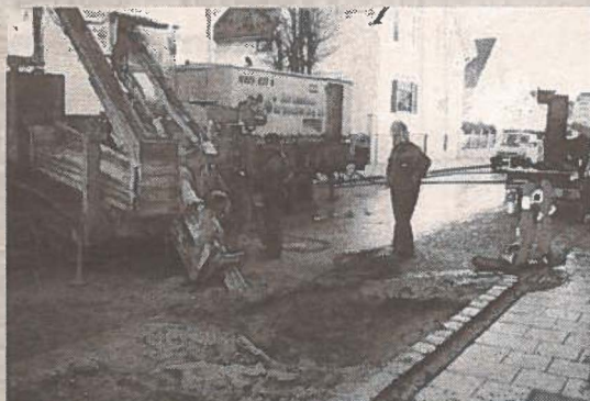
Svenn Inge Sagemyr og Kjell Jørgen Steinsholm fra firmaet Sørlandets Brønnboring har boret fem brønner på Storhaug. Brønnene skal stå i beredskap, slik at de kan brukes til å pumpe vann ned i grunnen, dersom grunnvannstanden skulle synke.
