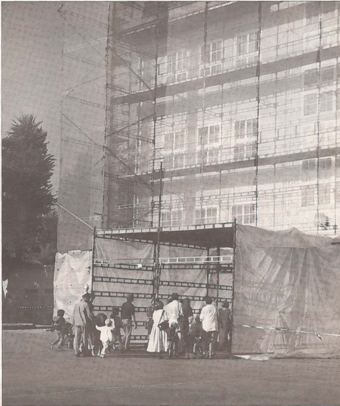
- Sikringstiltakene i forbindelse med takarbeidet var mangelfulle og vi måtte dermed gå i gang med å få opp et sikkerhetsnett. Det hersket mildt sagt en hektisk stemning de siste dagene, sier Frøydis Sirevåg Anthonsen, som er rektor på Nylund skole.
