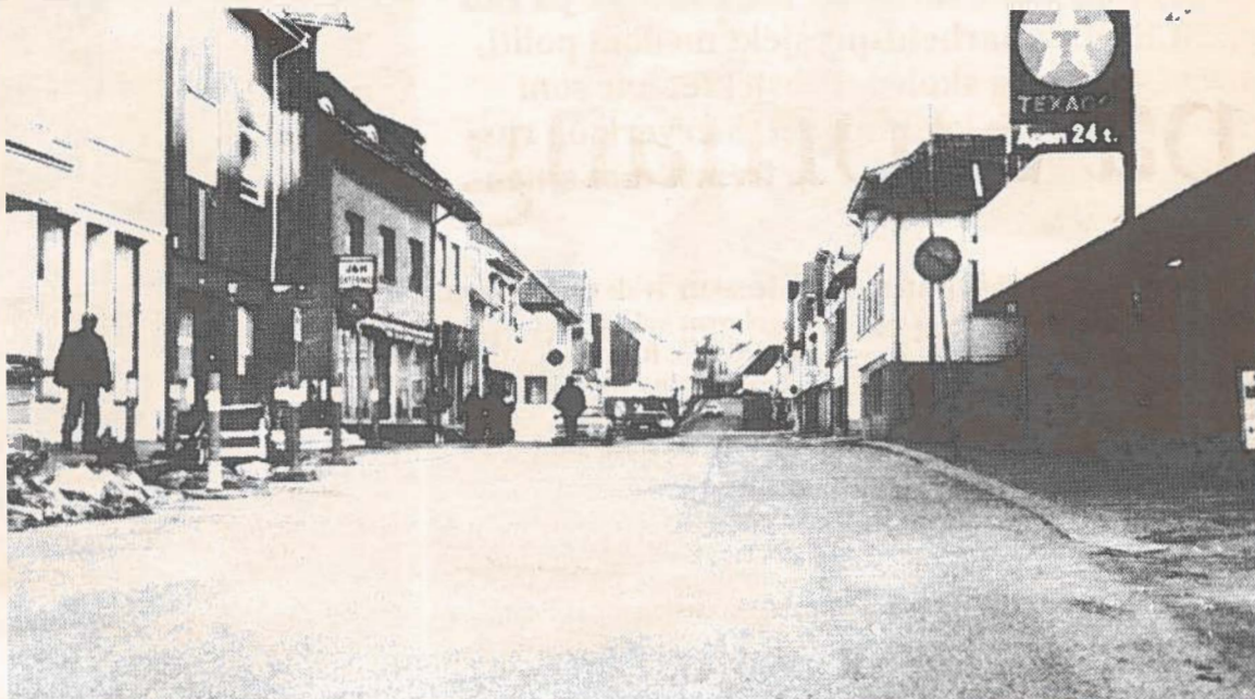
Endelig er turen kommet til Pedersgata. Ved årsskiftet starter opprustningsarbeidene.
