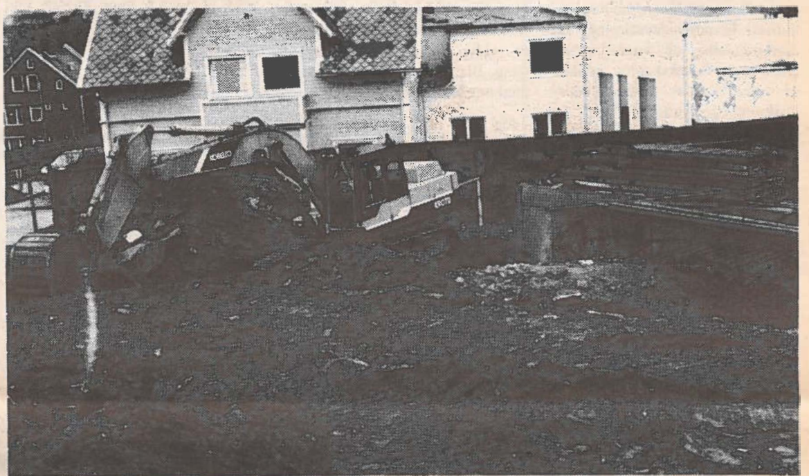
Kruse Smith er i full gang med fundamenteringen av eiendommen på krysset Kortegate-Bergelandsgate.
