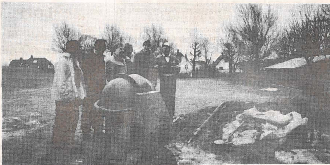
Noen fra dugnadsgjengen i gang med muring av murkant til isbanen.
