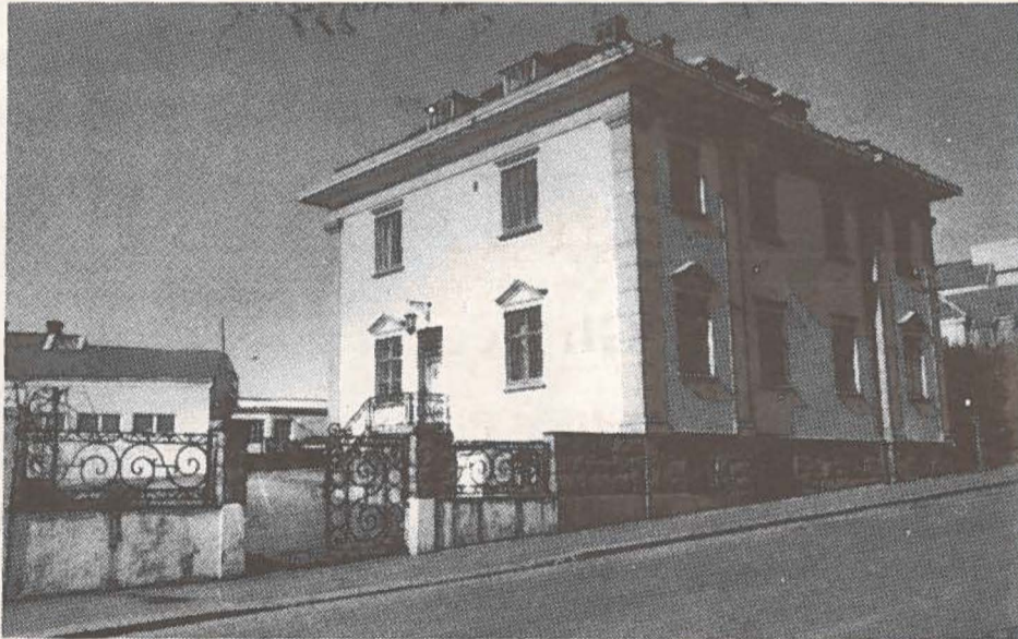
A/S Stavanger Tinfabriks kontorbygg skiller seg ut som et vakkert bygg med forseggjort smijerngjerde rundt gården. Bedriften satte sin ære i å ha et representativt utseende. I dag styress eiendomsdriften herfra.
