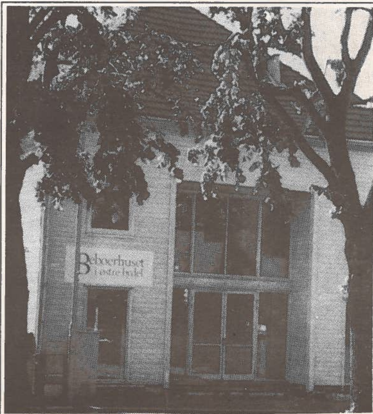
Beboerhuset begynner å ta form - men fortsatt venter dugnadsarbeid på å bli utført. Legg turen til Tårngata lørdag!
