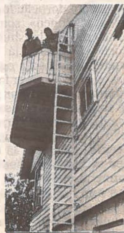
Trekk ut splinten og du har en solid stige.
