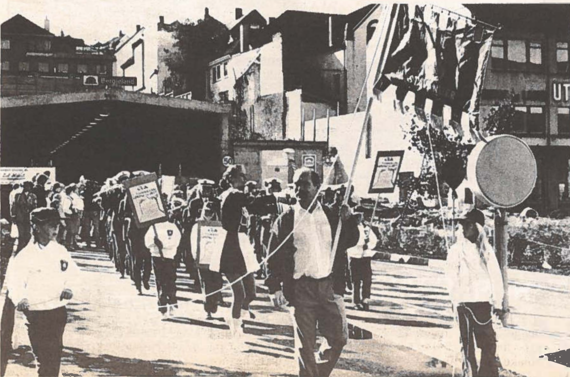
...og så: endelig gjennom. Tunnelen er erobret!
