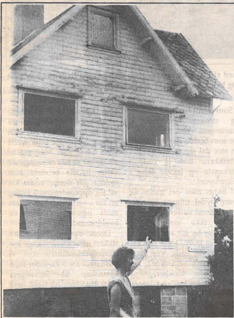
Avaldsnesgata 48 blir rehabilitert. Stavanger Byfornyelse har trukket tilbake den siste søknaden om riving.
