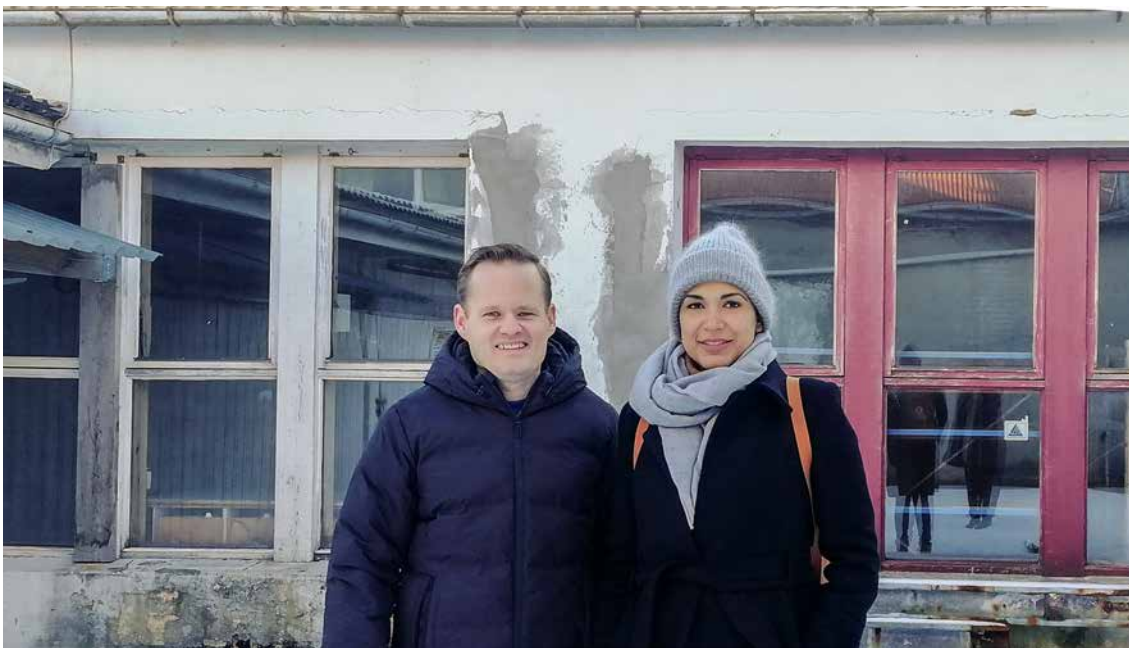
Anders Ohm og Patricia Mendez foran Nymansveien 40 a. - Her har det tidligere vært trykkeri, forklarer Anders og viser fram de romslige lokalene. – Taket må nok skiftes, men kontorlokalene er i rimelig god stand.
