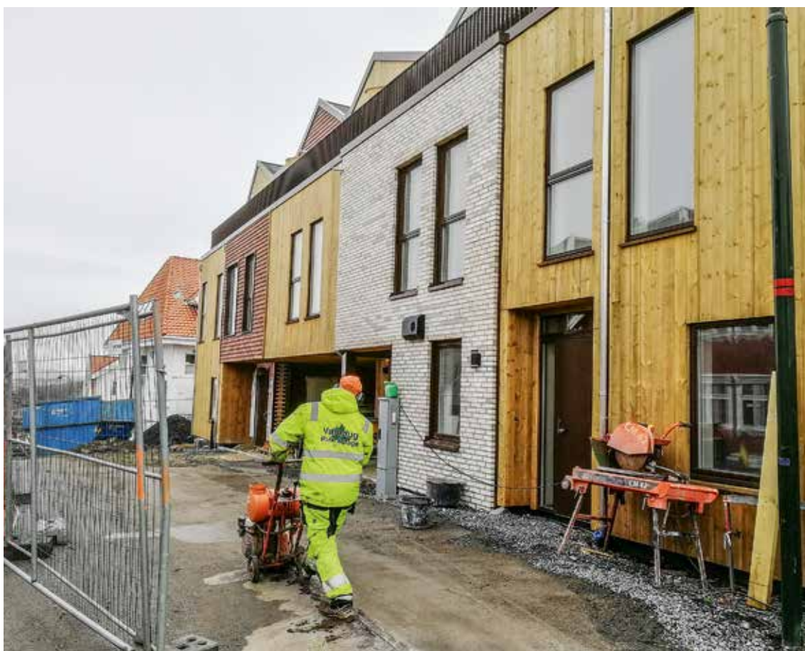
Det er straks klart for innflytting på toppen av Langgata.
