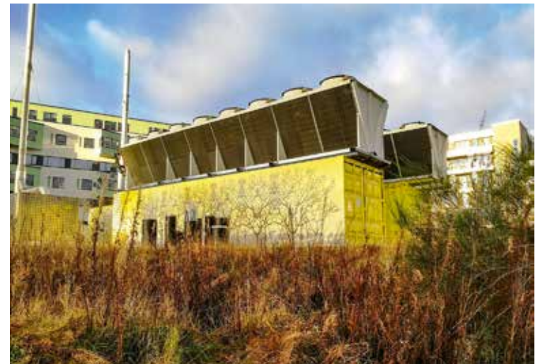
Den midlertidige gasskjelen for varmeproduksjon til boligblokkene og bedriftene blir demontert når spillvarmen fra Forus fyller rørene i stedet for gassvarme.
