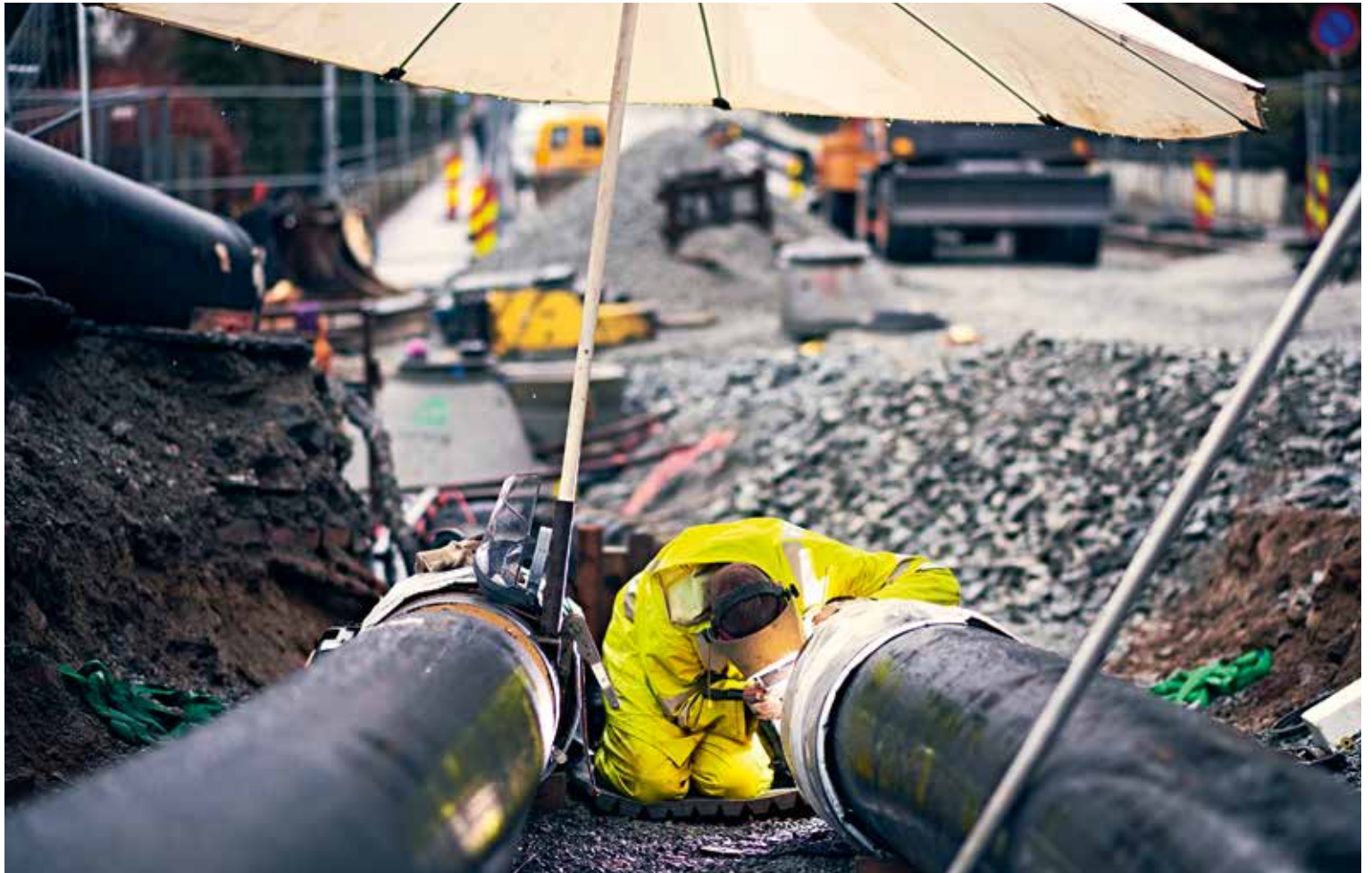
Fjernvarmerør strekker seg nå fra forbrenningsanlegget på Forus via Jåttåvågen og Hillevåg til Storhaugs østlige utbyggingsområder. Foto Kristofer Ryde.
