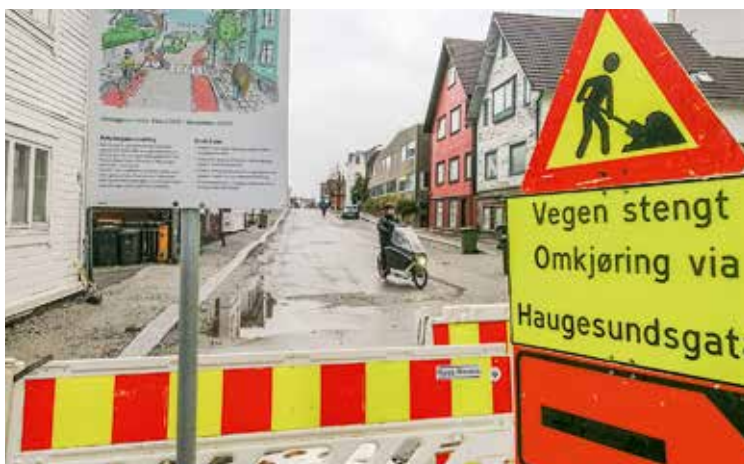
Arbeidet i Ryfylkegata vil vare til ut i 2021.
