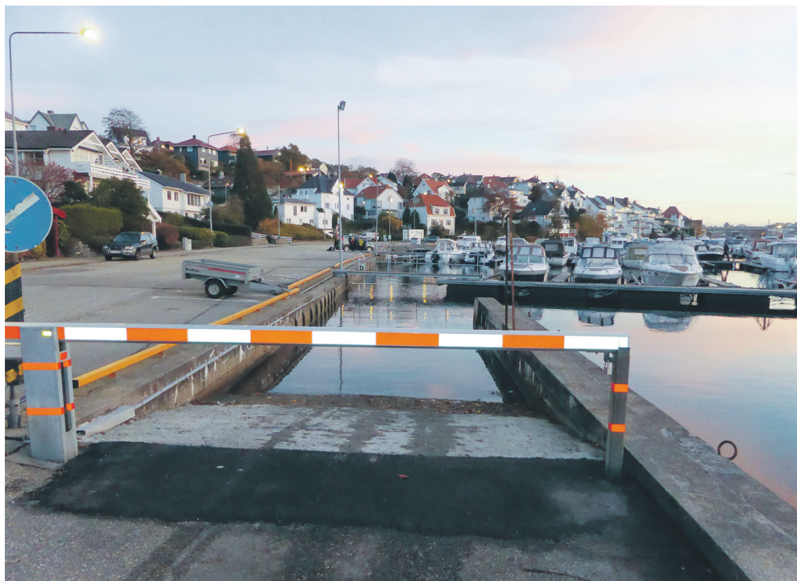
Båtrampe som tilhøyrrer Stavanger motorbåtforening (låst med bom).
