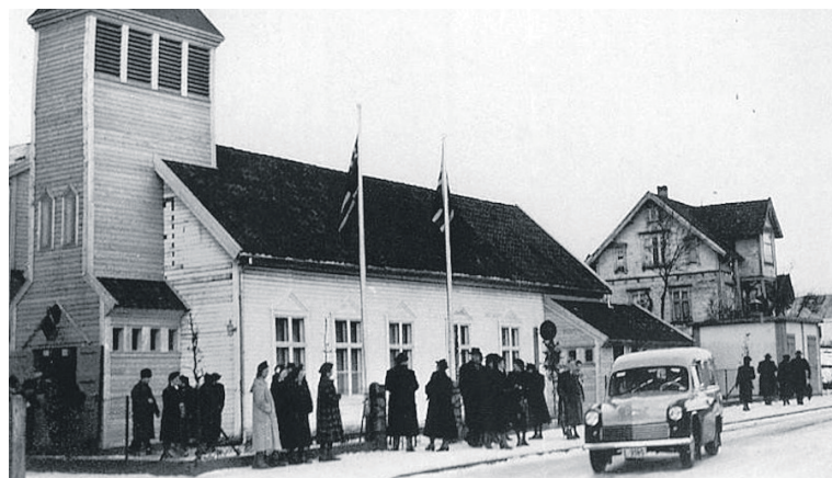
Hetlandsmarken kapell fungerte som kirke helt til menigheten fikk sin nye Varden kirke i 1967. Bygget ble revet i 1984 for å gi plass for en kombinert bygning for bolig og kontorer.
