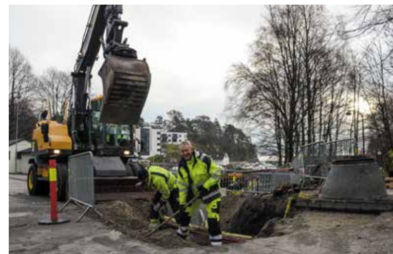
Ståle Fossestøl og Reidar Goa hos entreprenørfirma Torjussen legger nye avlastningsrør i Ramsvig båthavn.
