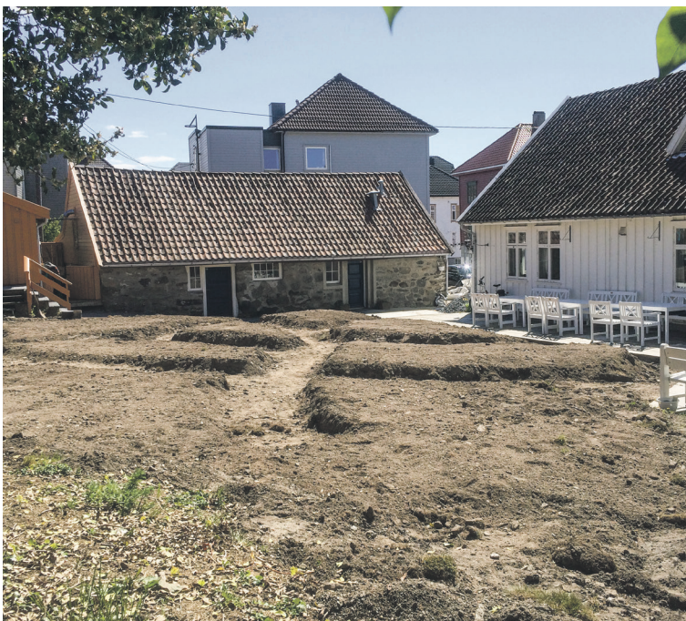
Vi hyret mann med gravemaskin som tok seg av den store og tunge jobben med å grave ut stier og bed, redusere hellingen og flytte store jordmasser.
