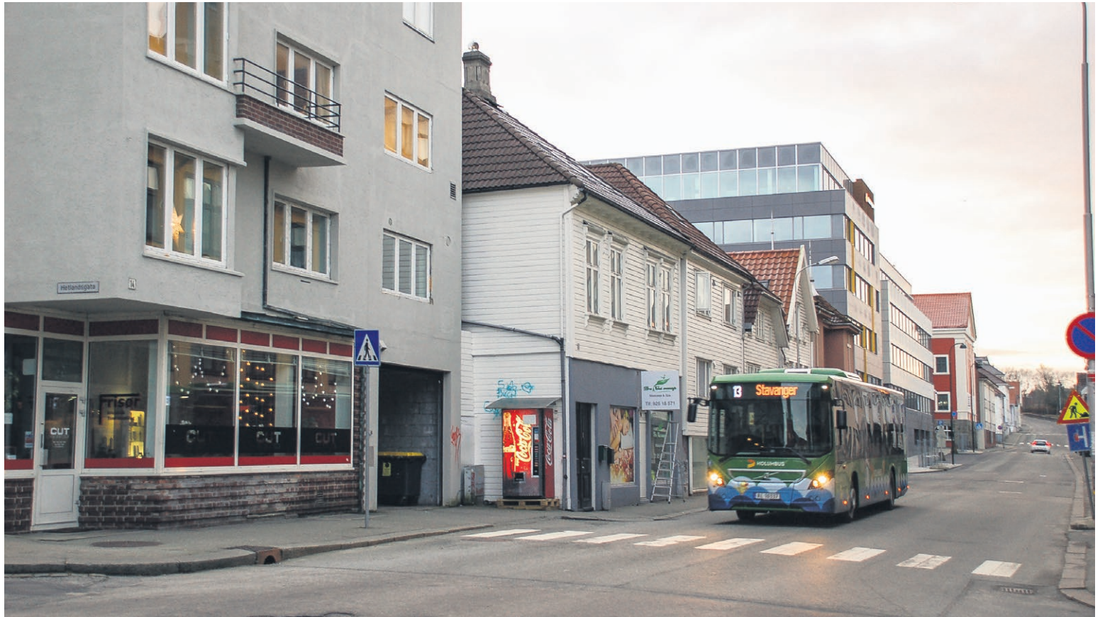
Planen innebærer at det kan rives 20 - 25 trehus langs Bergelandsgata som erstattes med ny bebyggelse på 4 - 5 etasjer, skriver fylkesrådmannen. Riksantikvaren fremmer innsigelse til riving i kvartalet Bergelandsgata – Stiftelsesgata – Vaisenhusgata – Erichstrupgate, trehus og murhus i kvartalet langs Bergelandsgata og Breibakken og i kvartalet Bergelandsgata - Hetlandsgata - Vaisenhusgata - Kirkebakken.
