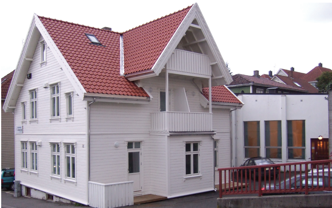
Blå Kors-huset i Bergelandsgata er totalrenovert for 3,8 mill. kroner. Blå Kors-salen til høyre.
