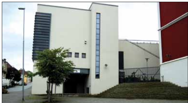
Bergeland videregående skole, Vaisenhusgata 50.
