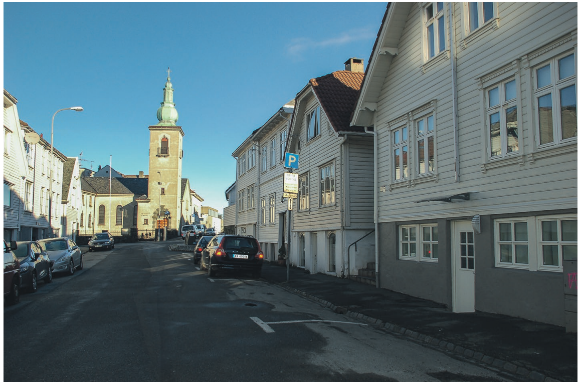
– Et av husene i Vaisenhusgata ble lovlig omregulert til utleieboliger med 14 boligenheter i et hus. Dessverre finnes ingen lovhjemler for å nekte dette, sa Roar Houen (V).
