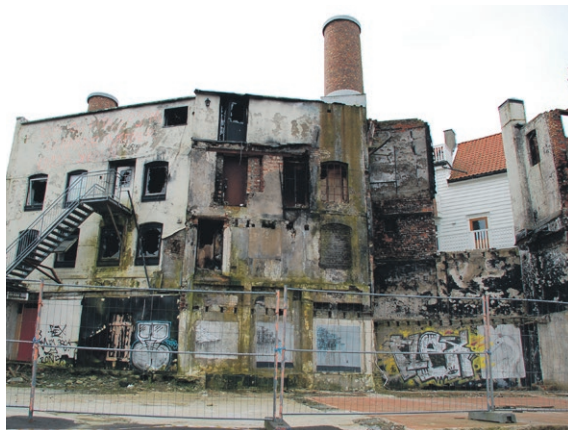
Verksgata 31 brant ned og ble totalt ødelagt 28. mai 2014.
