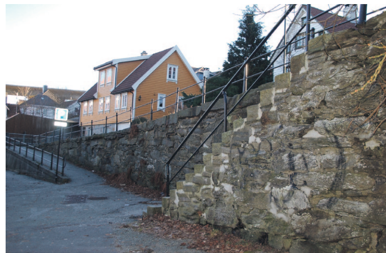
Den gamle steinmuren i Reidar Berges gate rehabiliteres.
