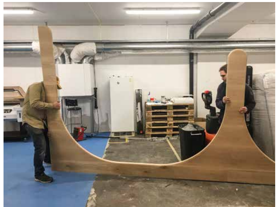
Omfattende rehabilitering utvendig og innvendig.
