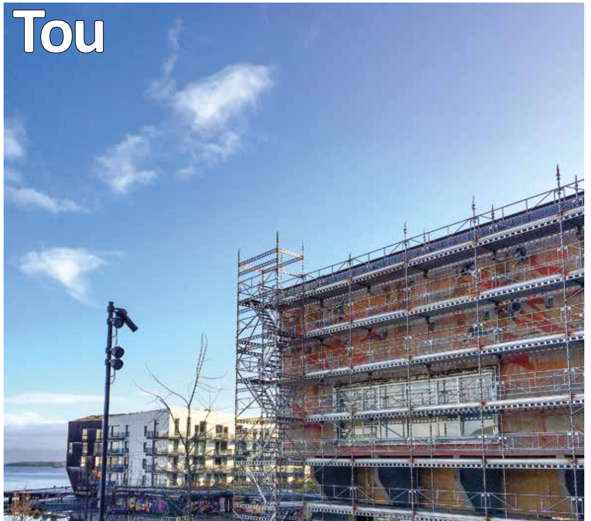
Fasadene skal pusses, sparkles og males i rødfargen som Tou er kjent for og vil derfor være påkledd stilaser med grønn netting i lang tid.
