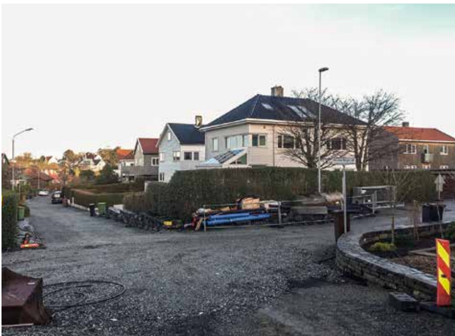
Hjelmelandsgata får fortau, og indre del av Kristine Berges vei blir gatetun for opphold, lek og trygg ferdsel.
