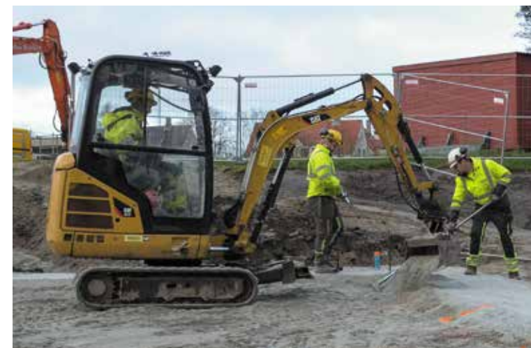
Ørjand Sande (i gravemaskinen), Vette Fløisvik og Henrik Braut fra Nordbo Maskin arbeider med den nye kunstgrasbanen på Midjord.
