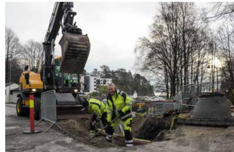
Ståle Fossetøl og Reidar Goa hos entreprenørfirma Torjussen legger nye avlastningsrør i Ramsvig båthavn.
