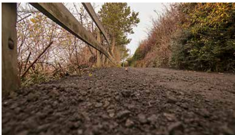
Det legges kald asfalt med ca 10 cm tykkelse. Foto Egil Bowitz.
