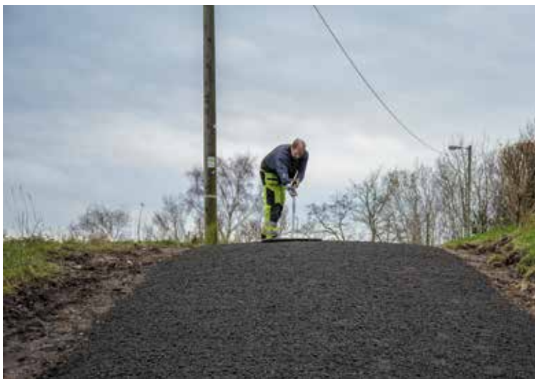
Kjetil Lie jevner ut asfalt-grusen før komprimering.
