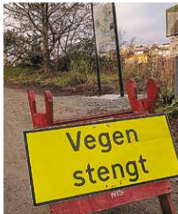
Skilt markerer hvor arbeidet pågår. Foto Egil Bowitz.
