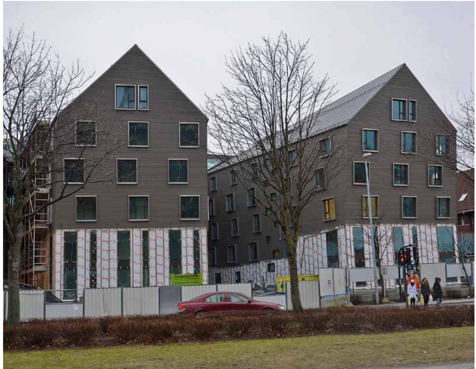
Hotellet på 6. etasjer har Øgreid som byggherre og Scandic som drifter. Foran hotellet lages et grøntområde med vannspeil og foran restauranten i første etasje til høyre vil det bli innlasset uteservering. Foto: Andreas Vollan
