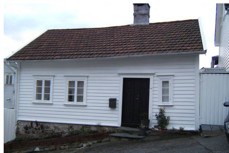
Her er laftekassen lagt oppå en tilpasset grunnmur i stein.
